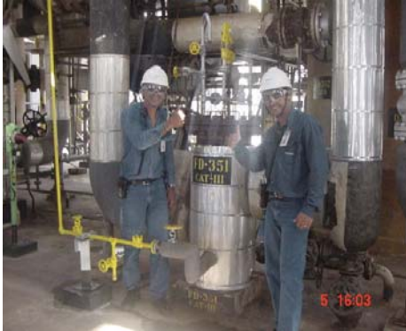
Foto-3: Sistema liberação de filtros
